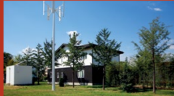
悬浮风机采用蓄电池储能系统，日发电量2kWh。
