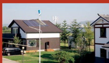
屋面和车棚配置光伏组件，总功率7.54kW，日均发电24kWh。
